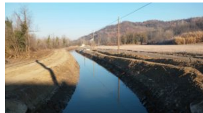
Il canale della centralina Noviconsult
