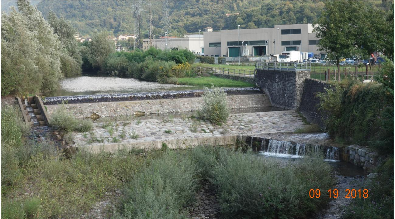
Da una valutazione empirica del modesto flusso d'acqua che scende dalla scala di rimonta del pesce (dimostratamente non idonea allo scopo) posta, sulla stessa derivazione, in sponda destra idraulica del torrente Grigna, scala ad oggi sprovvista di sistema di misurazione delle portate, impossibile stimare una portata pari ai 203 litri/sec mancanti sul totale di 283 l/s concessi.
