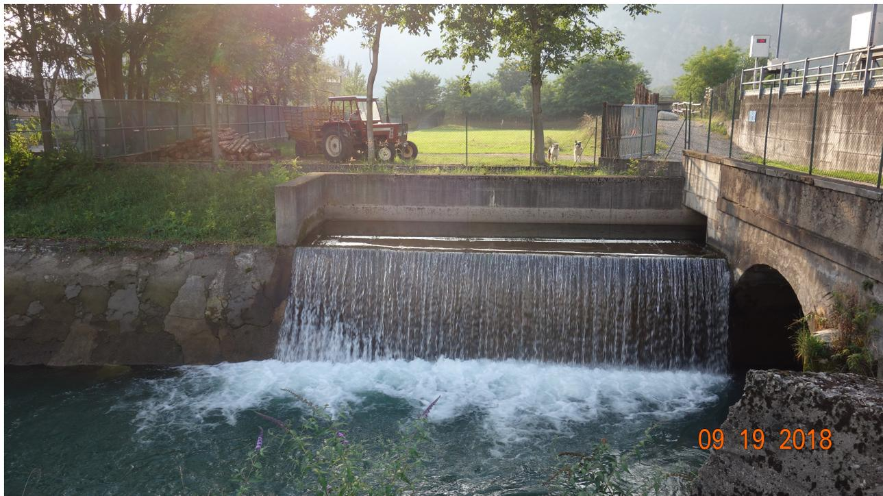
Oltremodo non ci capacitiamo del motivo per cui l'altezza della paratia continui a variare nell'arco del tempo, con valori che non possono essere giustificati con una possibile modulazione del DMV poiché esso deve rimanere costante o quanto meno mai inferiore ai 283ls ma è visivamente inferiore a tale portata
