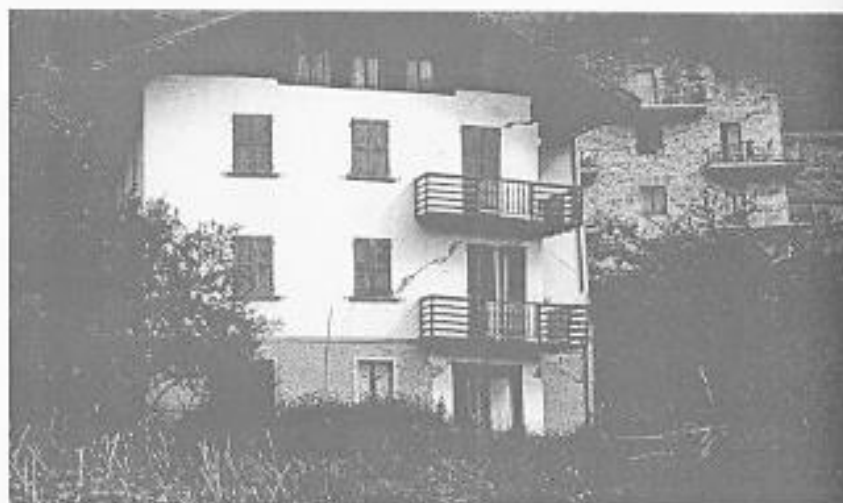
VECCHIO FABBRICATO SU DOLINA ORA DEMOLITO
