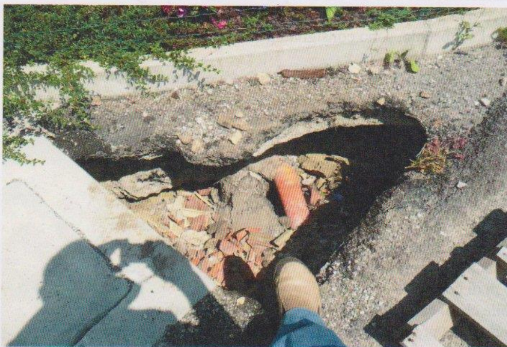
Figura 27 - Aspetti superficiali di sink-hole in copertura sciolta spessa oltre 70 m con substrato gessoso incarsito (Agordo).
