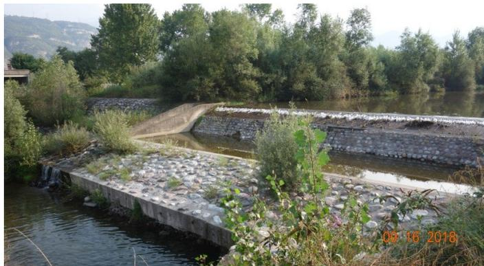
Derivazione impianto idroelettrico BKW Hydro Italia ed esempio di traversa insormontabile con scala di rimonta fauna ittica inadeguata
