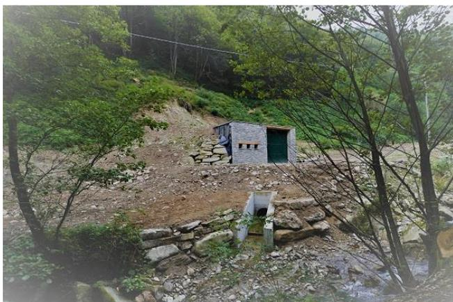
Lo stravolgimento della piccola valletta è evidente: l'adeguamento della strada ha coinvolto pesantemente il corso del torrente. L'edificio di presa, di rilascio e sala macchine sorgono su terreni di riporto.
